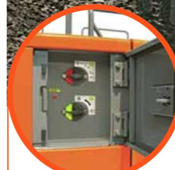
**Безопасность** Двойной изолирующий выключатель одновременно отключает стартер двигателя и аккумуляторную батарею, обеспечивая безопасность при проведении сервисных работ.
